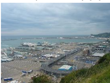
Slika 10.14. Ferry terminal u luci Dover, Velika Britanija [32]
