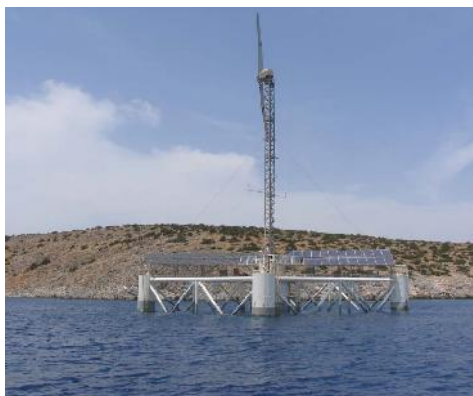
Slika 10.10. Konfiguracija plutajućeg vjetrogeneratora [16]
